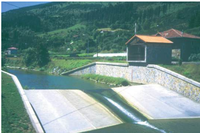
Figura 3. Estación de aforo de Gardea (cuenca del río Nervión). La información generada en la red de estaciones hidrometeorológicas constituye el punto de partida para cualquier análisis hidrológico, tanto para el análisis y prevención de avenidas como para la gestión integral de los recursos hídricos.
